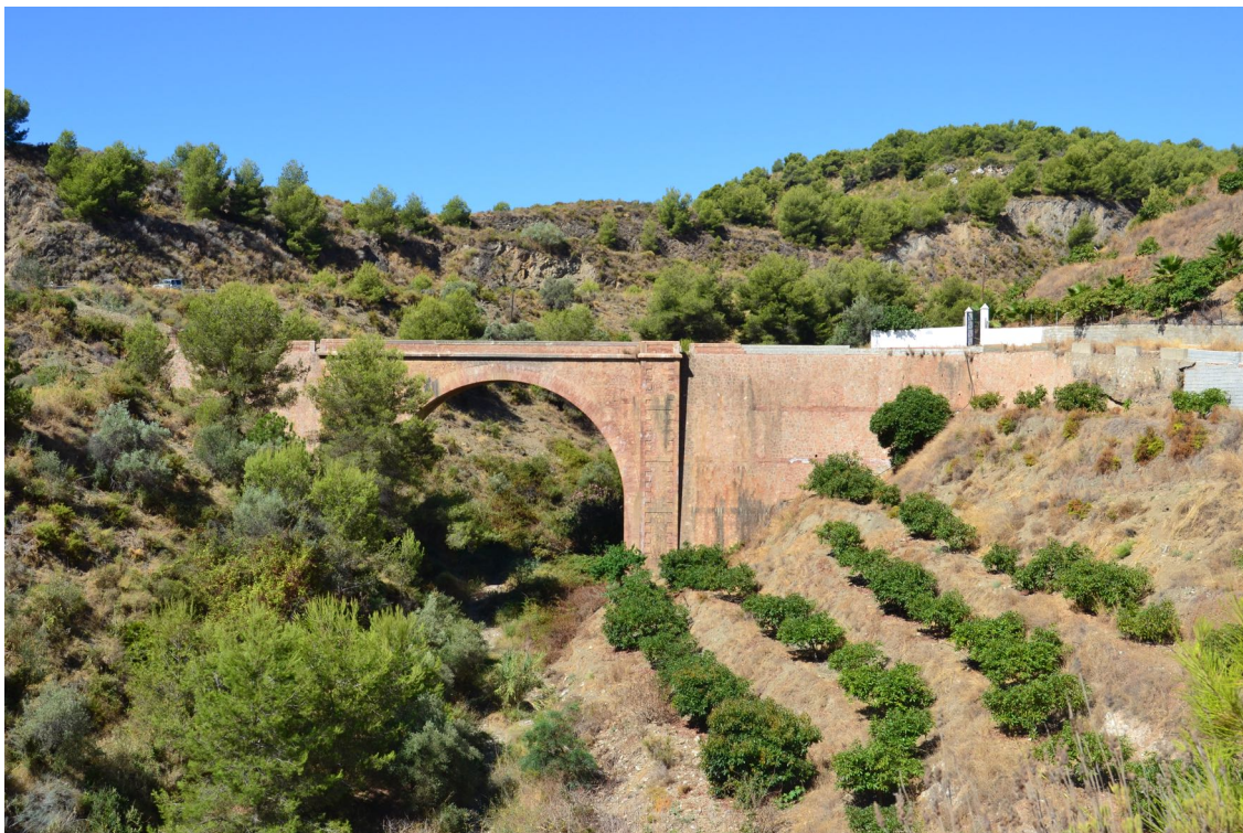
Figura 5. Uno de los viaductos gemelos de Maro, en un tramo aislado de la antigua carretera de la costa junto a Nerja
