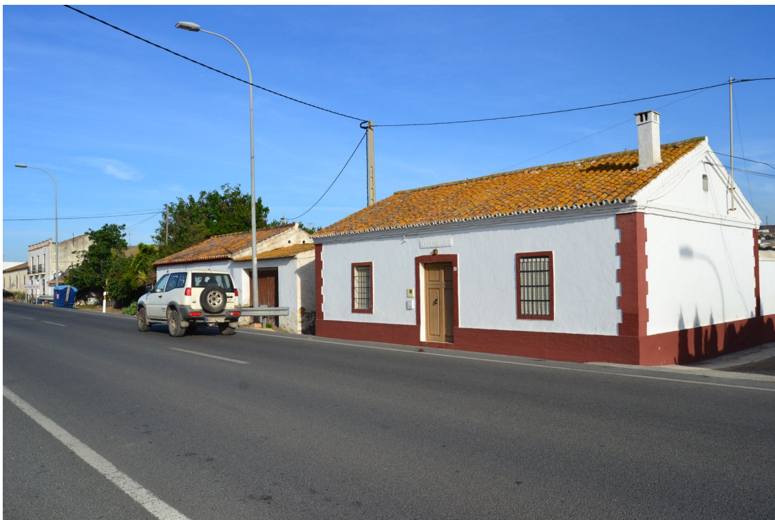
Figura 6. Casilla de peones camineros sin alterar en las proximidades de Torredelmar
