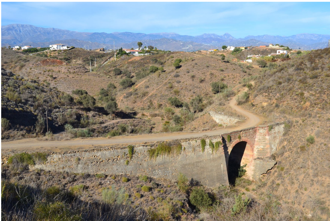
Figura 4. Puente del arroyo del Jaral y tramo intacto del camino del siglo XVIII junto a Almayate (Málaga)
