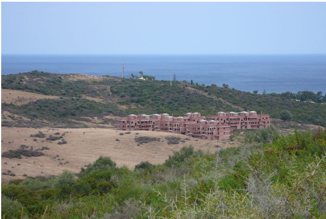
Figura 3. Autor: Jorge Izquierdo Cubero. Fotografía de la Obsolescencia. Edificaciones paralizadas debido a la crisis inmobiliaria en el paisaje litoral de Costa Casares. 2014.
