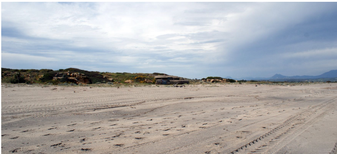
Figura 1. Autor: Alberto Atanasio Guisado. Búnker IA28. Búnker en dos niveles para dos ametralladoras y un anticarro, construido como prolongación de la ladera que baja hasta la playa. Playa de Punta Mala, San Roque. 27/04/2015
